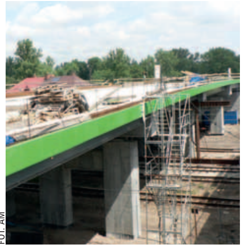
Pierwszy z wiaduktów nad torami kolejowymi – w budowie
